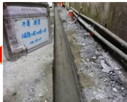
新建 雨水排水溝
