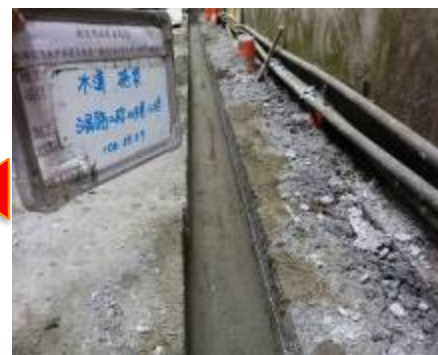
新建 雨水排水溝
