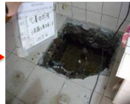
化糞池打除 接管.回填
