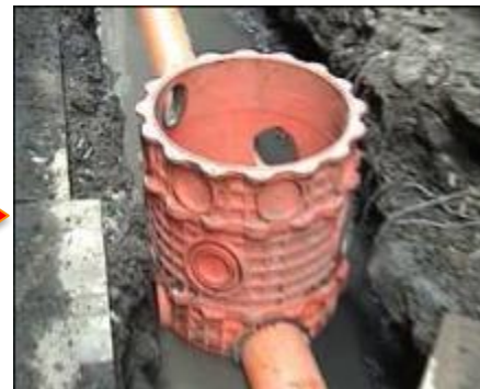
後巷開挖 污水設施埋設
