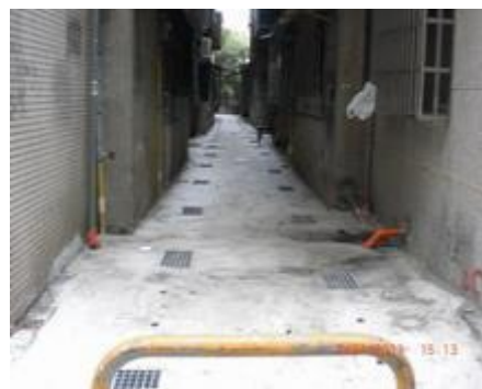
鋪設後巷 混凝土地坪
