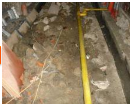
後巷民生管線永遷 (自來水、瓦斯)
