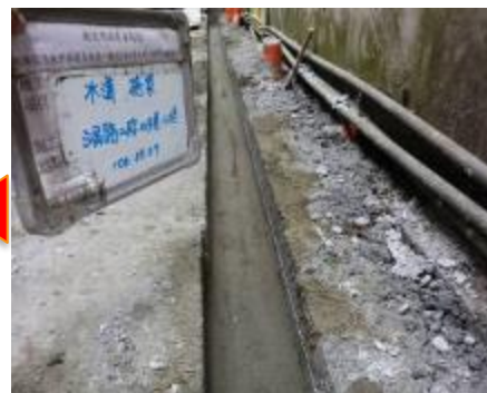
新建 雨水排水溝
