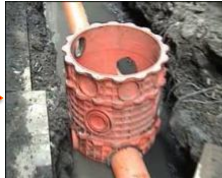
後巷開挖 污水設施埋設
