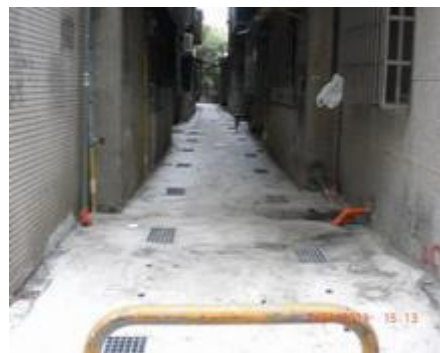
鋪設後巷 混凝土地坪
