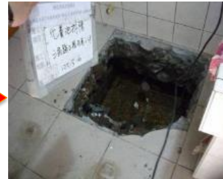
化糞池打除 接管.回填
