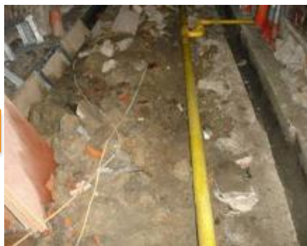
後巷民生管線永遷 (自來水、瓦斯)
