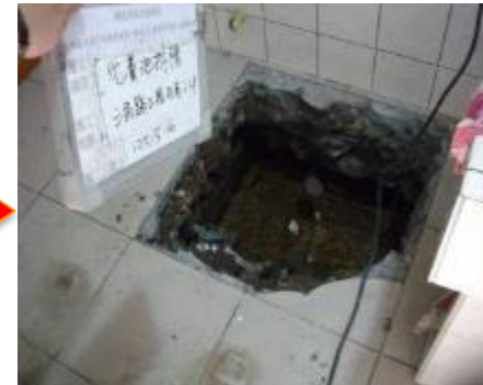
化糞池打除 接管.回填
