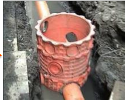
後巷開挖 污水設施埋設
