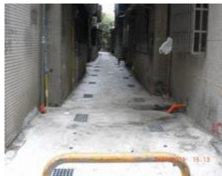
鋪設後巷 混凝土地坪
