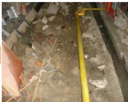
後巷民生管線永遷 (自來水、瓦斯)
