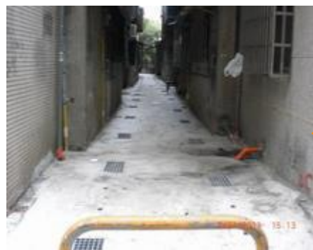
鋪設後巷 混凝土地坪
