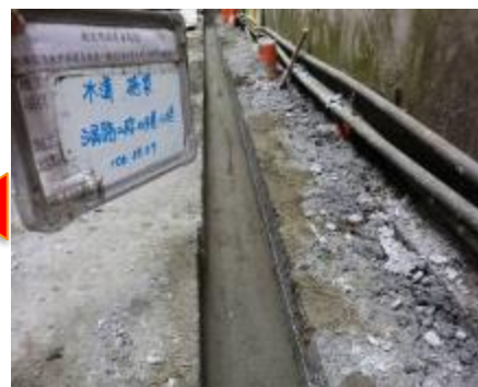
新建 雨水排水溝
