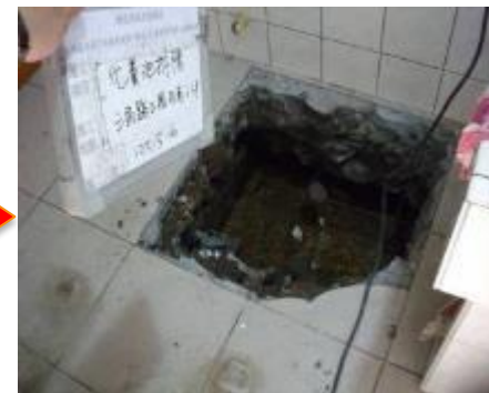
化糞池打除 接管.回填
