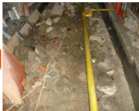
後巷民生管線永遷 (自來水、瓦斯)
