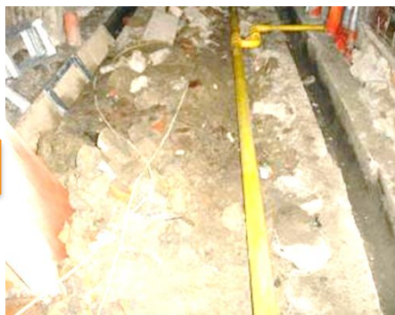
後巷民生管線永遷 (自來水、瓦斯)
