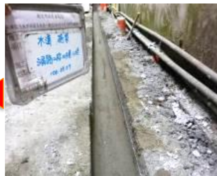
新建 雨水排水溝
