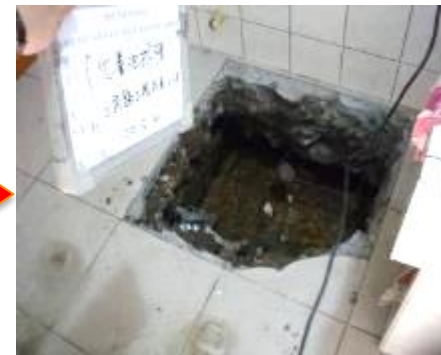
化糞池打除 接管.回填
