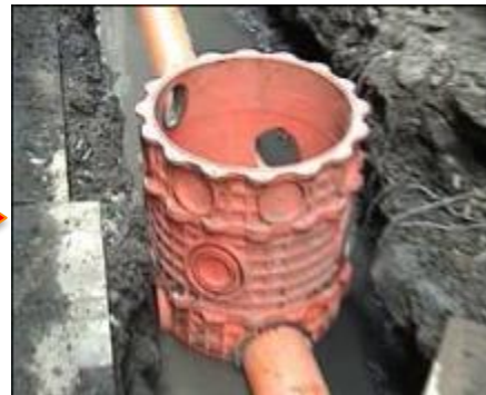
後巷開挖 污水設施埋設
