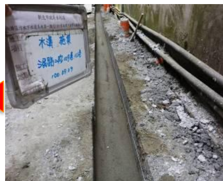
新建 雨水排水溝
