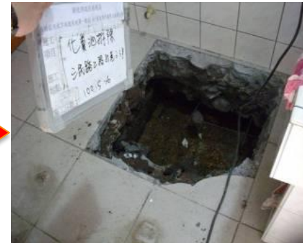
化糞池打除 接管.回填
