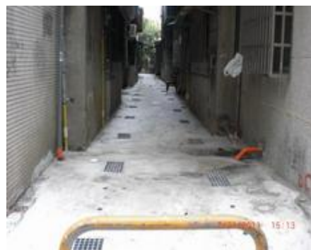
鋪設後巷 混凝土地坪
