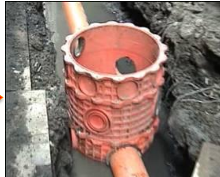
後巷開挖 污水設施埋設
