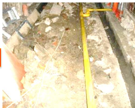
後巷民生管線永遷 (自來水、瓦斯)
