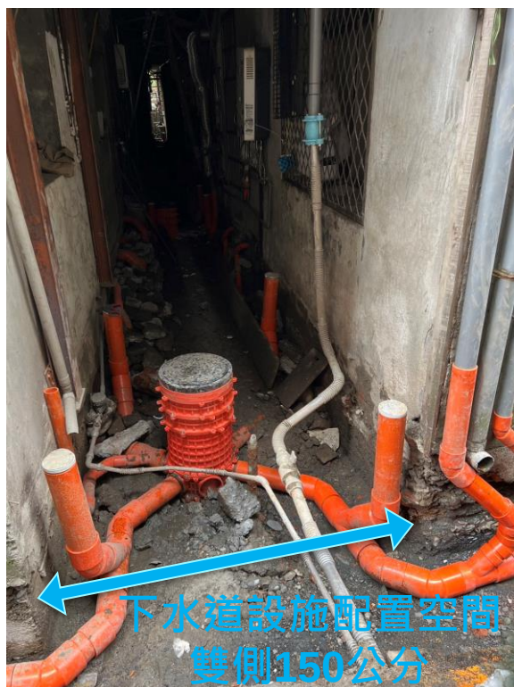
施工中(雙側接管)
