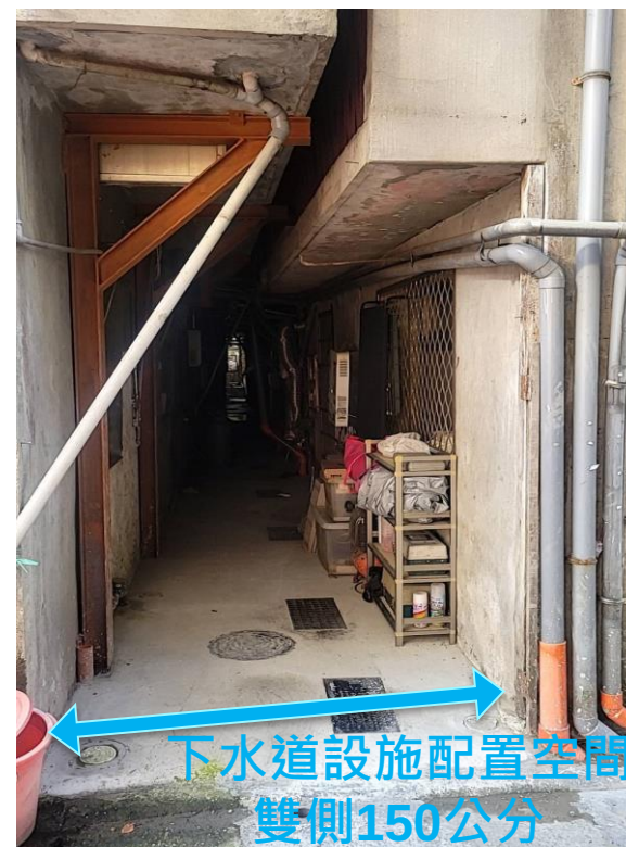
施工後(新築水溝)
