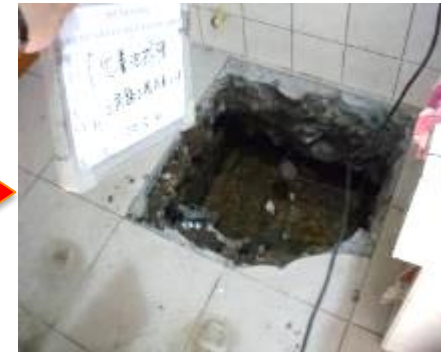
化糞池打除 接管.回填
