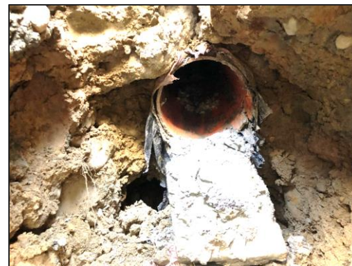
自設陰井管線銜接
