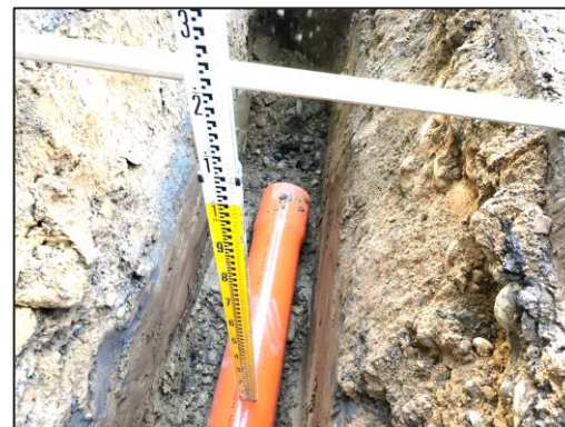
污水管線埋設
