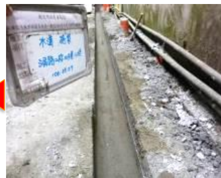
新建 雨水排水溝
