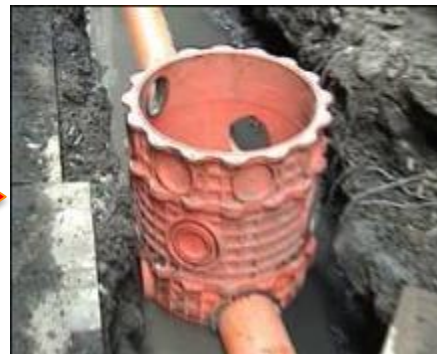
後巷開挖 污水設施埋設
