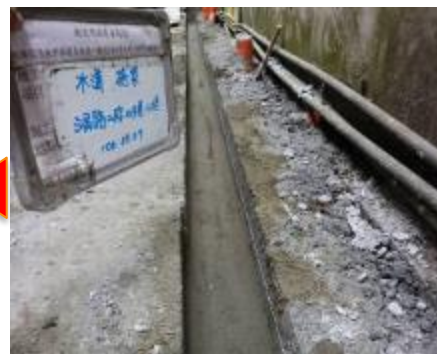
新建 雨水排水溝
