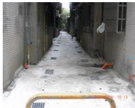
鋪設後巷 混凝土地坪
