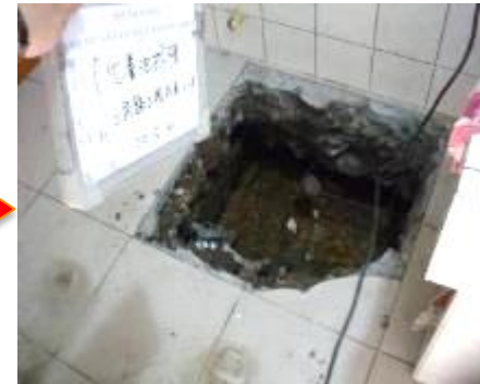
化糞池打除 接管.回填
