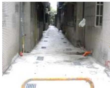
鋪設後巷 混凝土地坪
