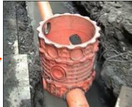
後巷開挖 污水設施埋設
