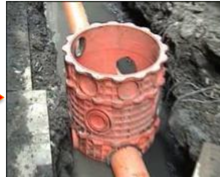
後巷開挖 污水設施埋設
