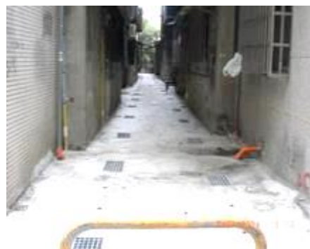
鋪設後巷 混凝土地坪
