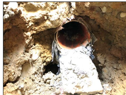
自設陰井管線銜接
