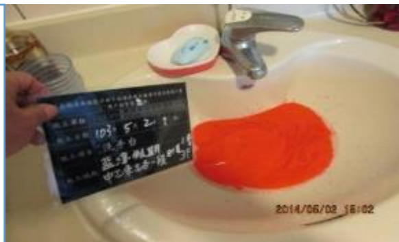
⑦ 雨、污水管投色劑試水確認
