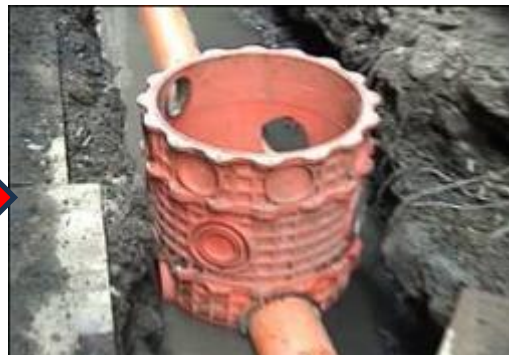
⑧ 後巷開挖 污水設施埋設
