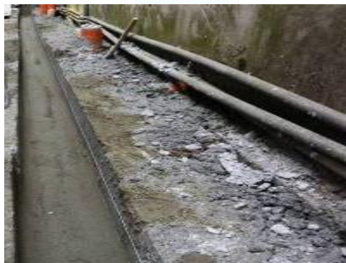
⑪ 新建 雨水溝
