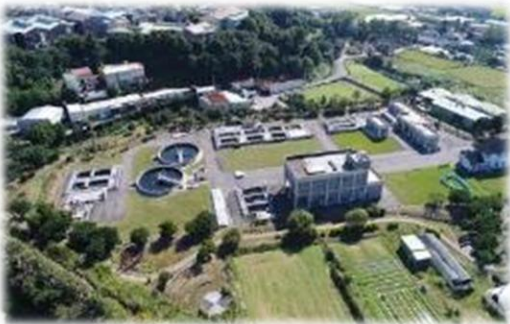
大溪水資源回收中心
