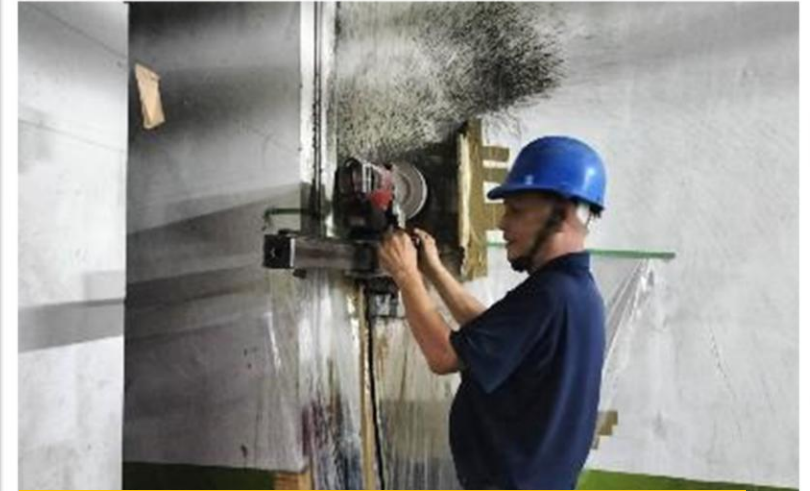
污水管預計接出位置B1牆面洗洞
