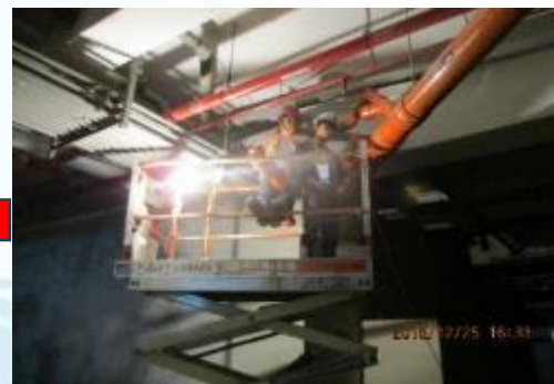
⑥ 大樓內部改管主管線佈設
