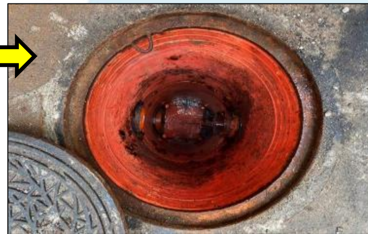
污水管內 乾淨無阻塞
