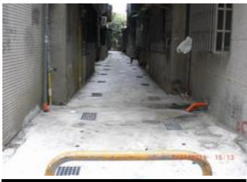
⑫ 施工後後巷 鋪設混凝土地坪
