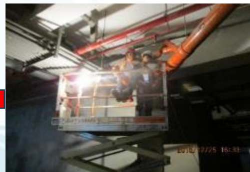
⑥ 大樓內部改管 主管線佈設
