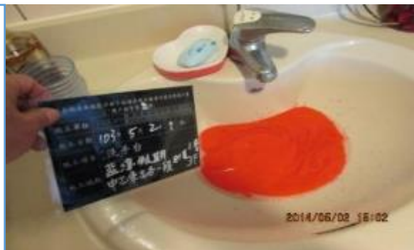
⑦ 雨、污水管投色 劑試水確認
