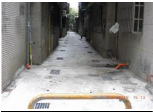
⑫ 施工後後巷 鋪設混凝土地坪
