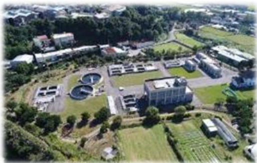
大溪水資源回收中心
