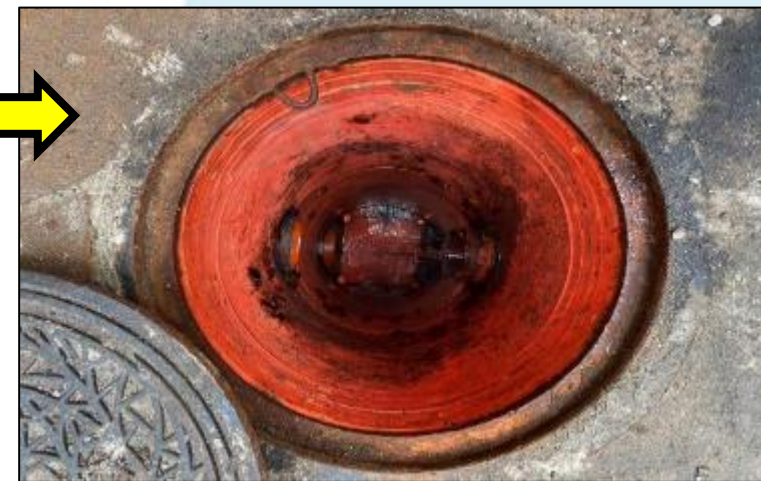
污水管內乾淨無阻塞
