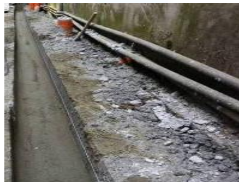
⑪ 新建 雨水溝
