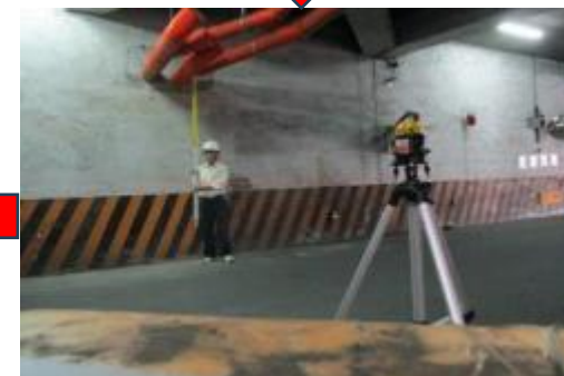
⑤ 施工現場放樣 出水口放樣
