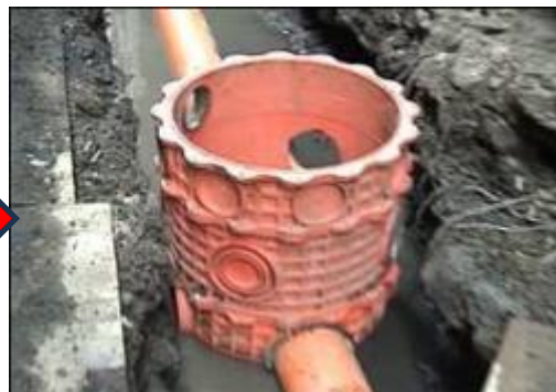
⑧ 後巷開挖 污水設施埋設
